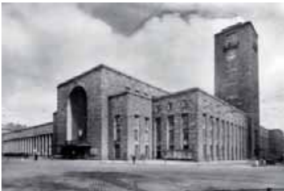
Paul Bonatz, Hauptbahnhof Stuttgart, 1910-1928 Aufnahme um 1930. Foto: Bonatz-Archiv bei Peter Dübbers, Stuttgart
